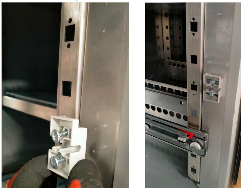
Foto 8:Instalación de soportes espaciadores.
