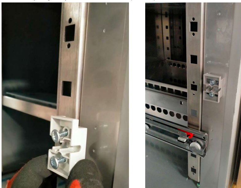
Foto 8: Colocação de suportes do separador.
