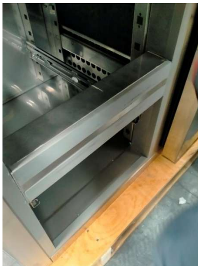
Foto 11: Colocação do separador.
