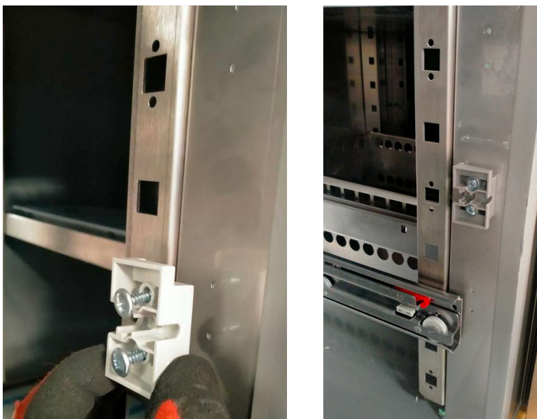
Foto 8:Installatie van afstandhouders.
