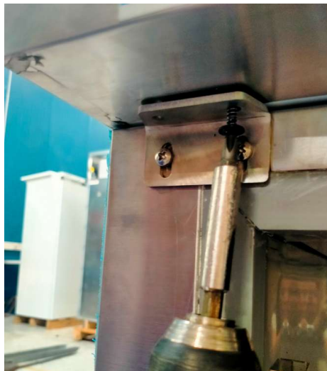
Foto 4: Nieuwe lagere steun.
