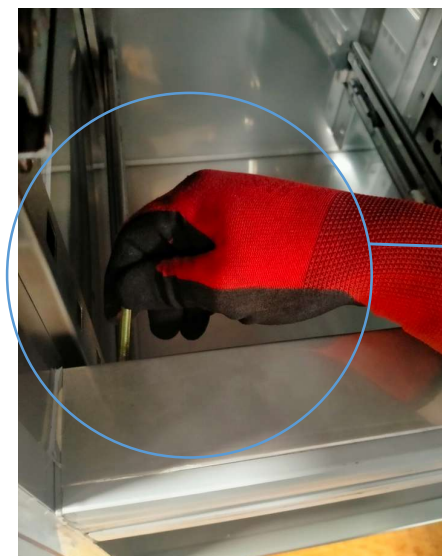
Foto 12: Fissaggio del distanziatore.
