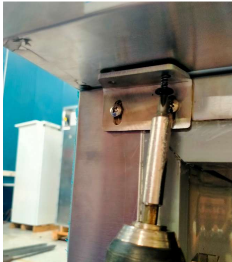
Photo 4 :Nouveau support inférieur.
