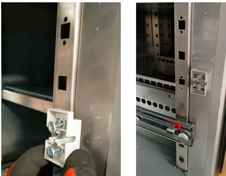
Photo 8 : Installation des supports d'espacement.
