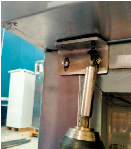
Foto 4:Neue untere Stütze.
