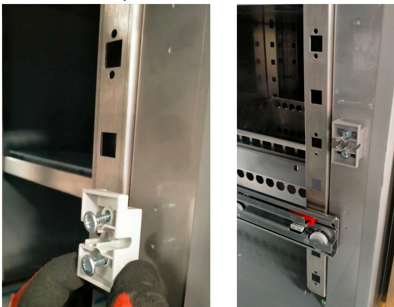
Foto 8: Instalación de soportes espaciadores.
