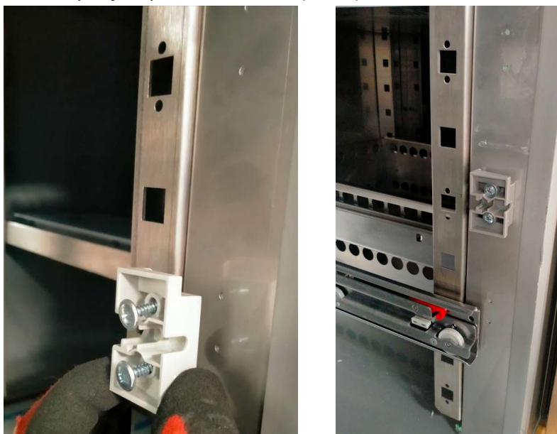
Foto 8: Colocação de suportes do separador.
