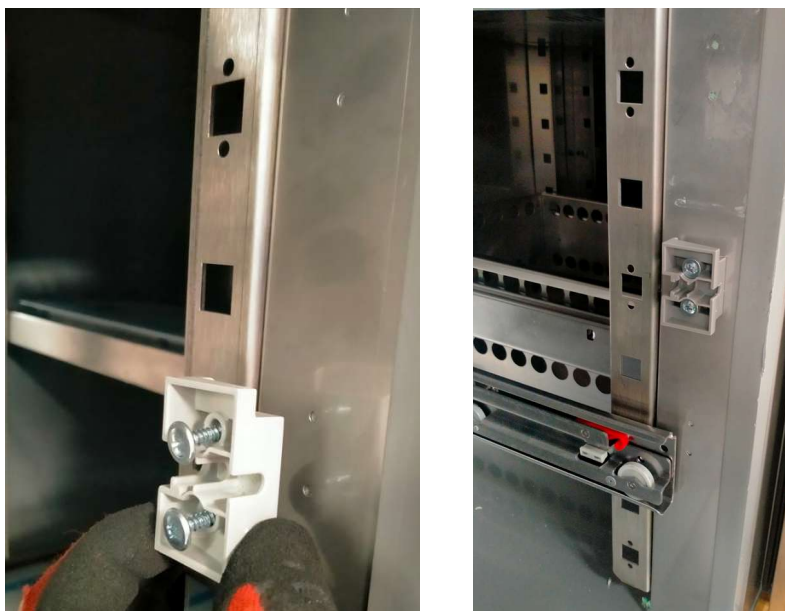
Foto 8:Installatie van afstandhouders.
