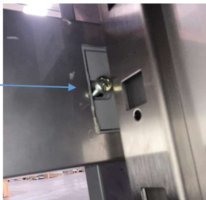
Foto 12: Bevestiging met afstandstuk.
